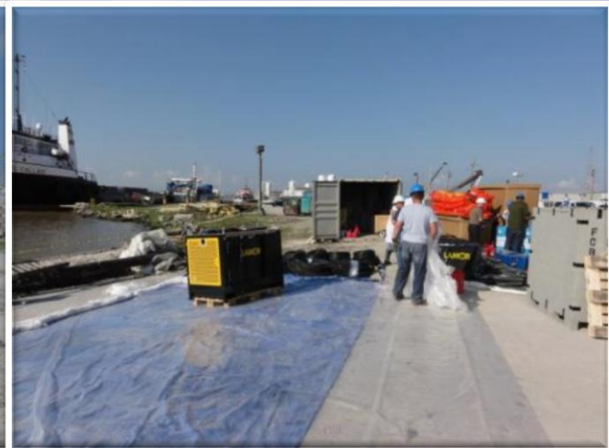
資機材の到着
