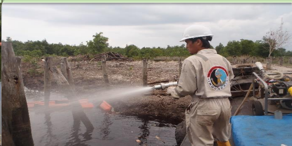
2014年5月24日 植物に付着した油を高圧温水で清掃
