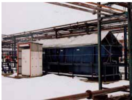
実験水槽全景
