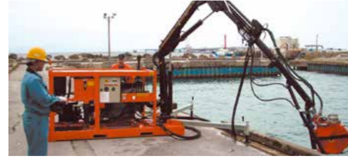
移送ポンプシステム (デスミ・ロークリーン社、デンマーク)
