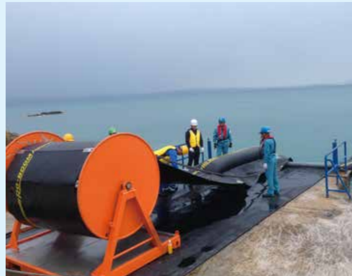
オイルフェンスの展張 Deployment of Oil Boom
