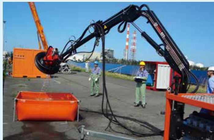
移送ポンプシステムの操作訓練 Operation of Crane Sweep System
