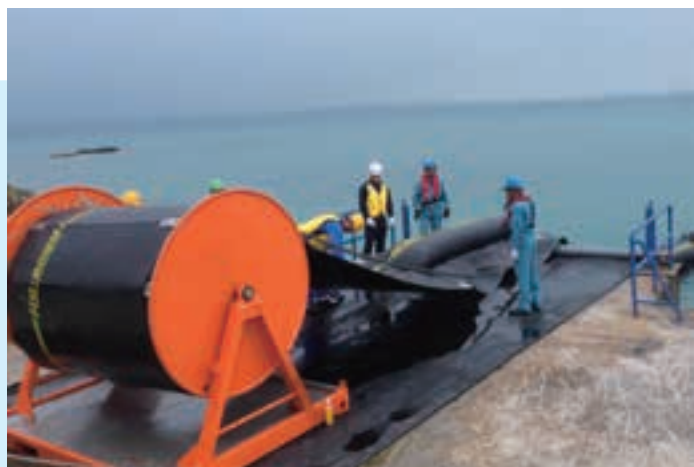
オイルフェンスの展張 Deployment of Oil Boom
