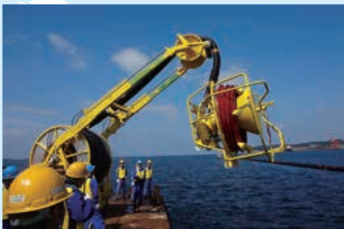
大型油回収機の投入 Use of Large Skimmer
