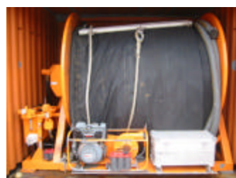
NO. 1コンテナブーム正面内部
