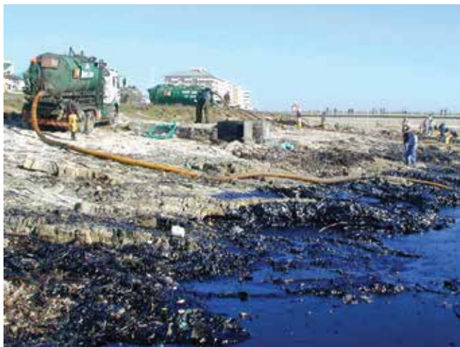
▲ 図8：真空吸引システムはどこでも調達しやすいため、海岸線又は付近の水域で油を回収するのに最適の装置である。
