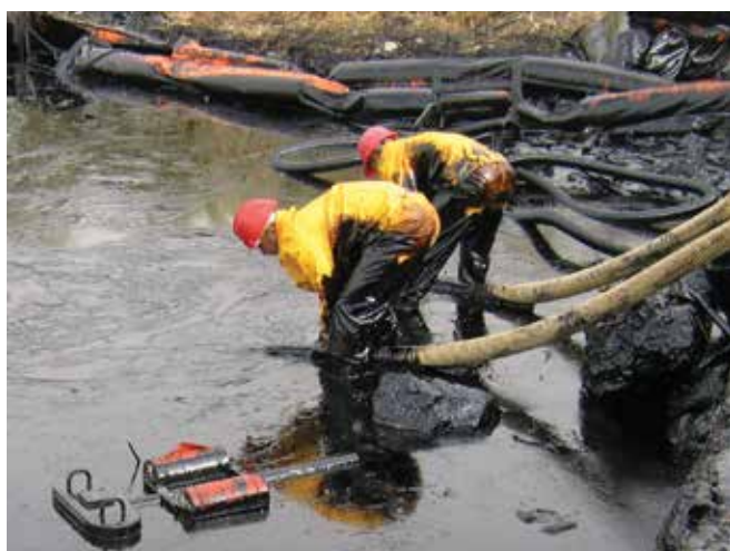
▲ 図10：真空ポンプに接続されたホースを直接油の中へ投入している作業員。この事例では、小型の堰部品が取り外され、高粘度重油がホースへ流入できる。但し、同伴水が増加する可能性がある。
