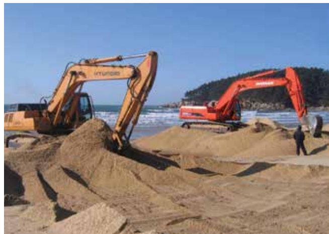
▲ 図18：軽度に汚染された砂は、潮間の磯波帯へ移され、その後の潮汐によって洗浄される。
