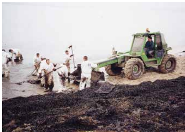
▲ 図8：油及び油で汚染された海草を伸縮バケツに入れる手作業による除去。この方法は、油で汚染された物質を優先的に選択できるため、廃棄物の量を最小限度に抑えられる。
